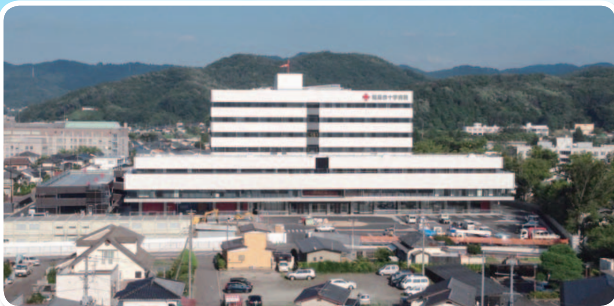
(平成30年7月末現在 現病院屋上より撮影)
